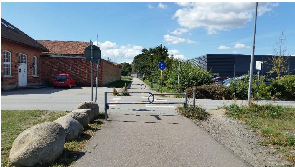
Figur 17. Befintlig cykelpassage där Regementsgången korsar Adlercreutzgatan. De dubbla fällorna har gjort att cyklister och fotgängare skapat ett nytt stråk vid sidan om passagen.
