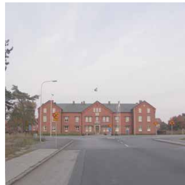
Gamla kanslibyggnaden på Regementsområdet i Ystad
