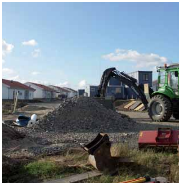
Byggarbetsplats i Västra Sjösten
