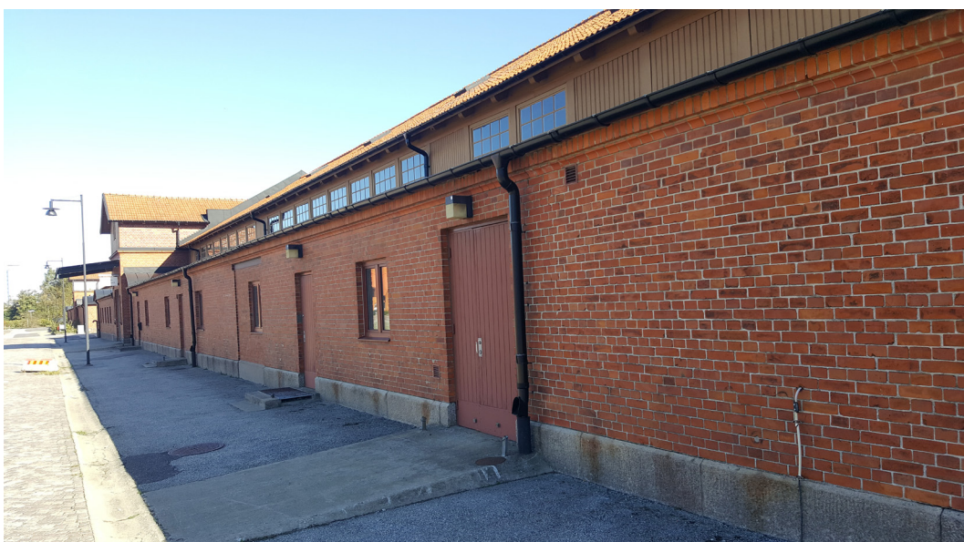
Stallets västra fasad.
