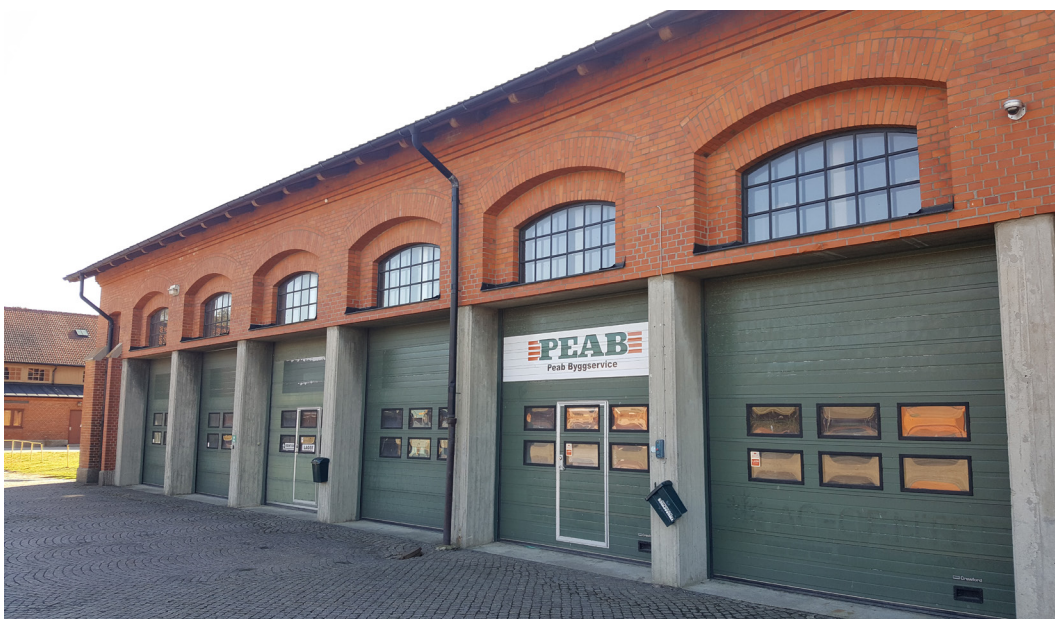
Ridhusets norra fasad.
